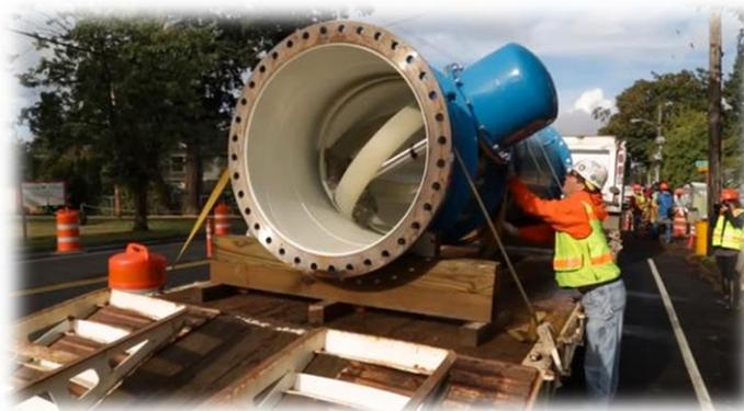
Figura 15 Installazione di Lucidpipe a Portland ([www.nextech](http://www.nextech))
