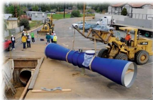
Figura 16 Installazione di Lucidpipe a Riverside (California) ([www.ijsge.com](http://www.ijsge.com))
