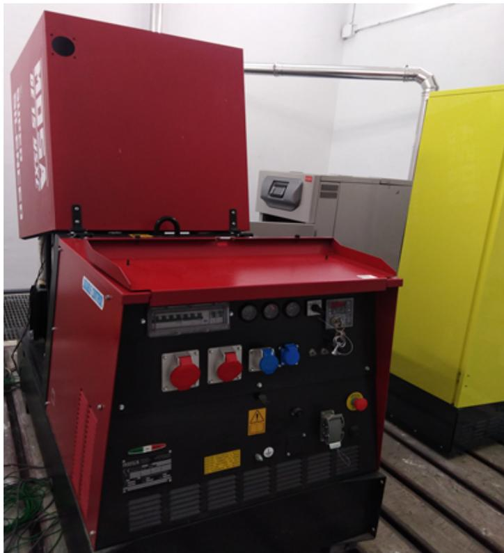
**Figura 1:** Unità di generazione basata su un motore a combustione interna
