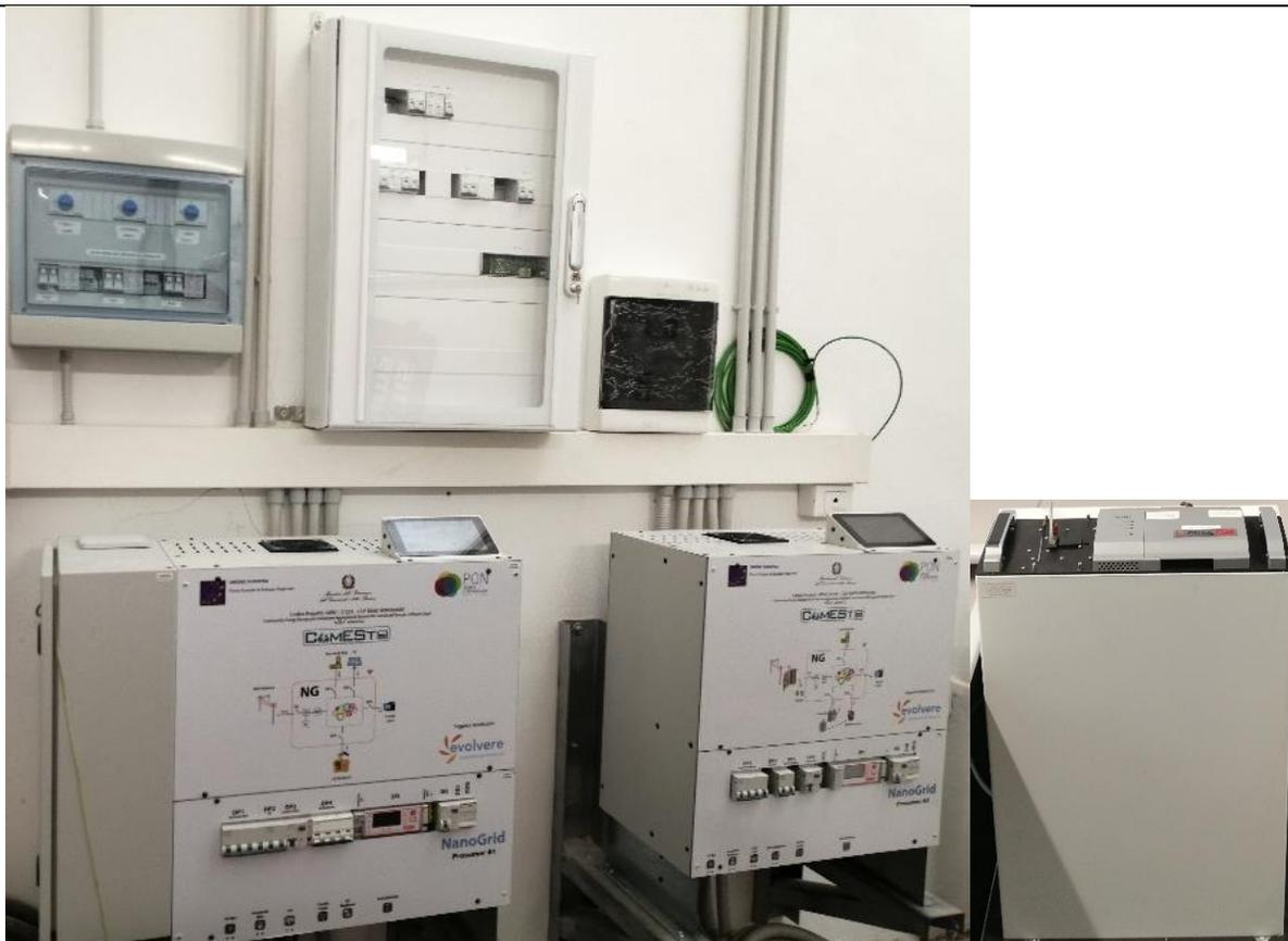
NG5 con impianto fotovoltaico e generatore a biodiesel a sinistra, NG4 con sistema di accumulo a Litio e interfaccia con Elettrolizzatore e Fuel-cell a destra.
